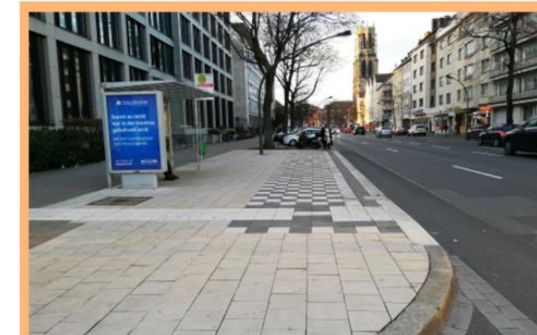
Ausbau barrierefreier Haltestellen inkl. Zuwegung
